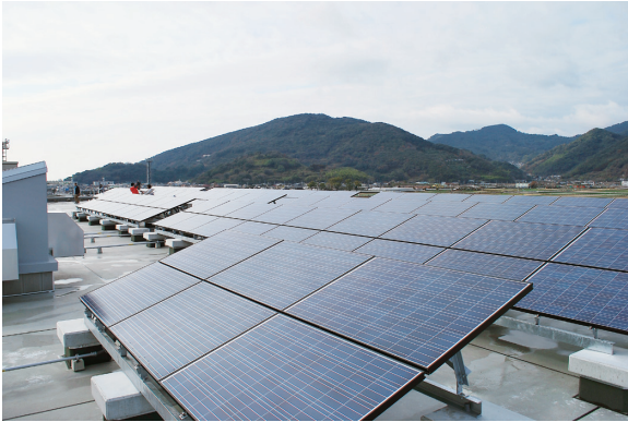
▶西区役所屋上に設置した30kW太陽光発電パネル。東区役所にも同様の設備がある
